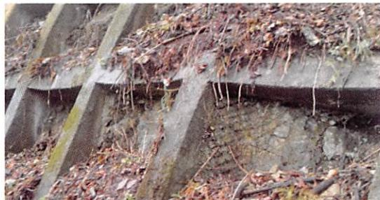
写真-2 在来種を用いた法面の植生衰退状況
